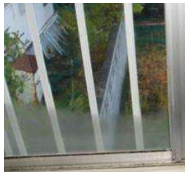
<施工後> 朝方 結露の改善
